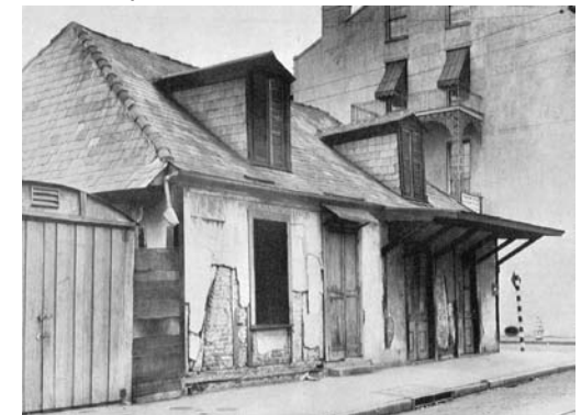
Fig. I.B.5 Brique-entre-poteaux construction
